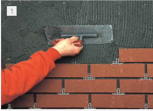
1 İşıklar Flex Yapıştırıcı malzeme yüzeye 8-10 mm taraklı mala ile uygulanır. // İşıklar Flex Adhesive material is applied to the surface by using 8-10 mm notched trowel.
