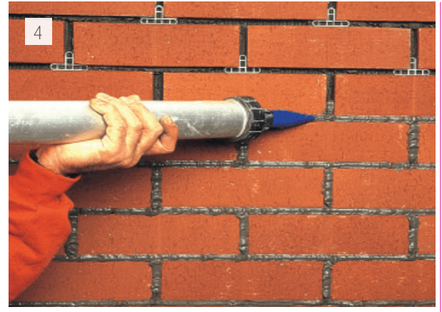
4 Derz dolgusu tabancası yardımıyla tuğla yüzüne bulaştırmadan uygulanmalıdır. // The joint filler should be carefully applied to the brick surface with a sealant gun.
