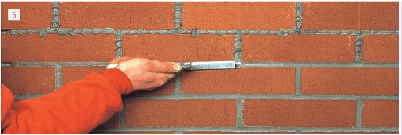
5 Derz dolgusu elle yapışmayacak kadar kuruyunca derz malası yardımı ile şekillendirilmelidir. // After joint filler is dried enough, it should be shaped with a pointing trowel.
