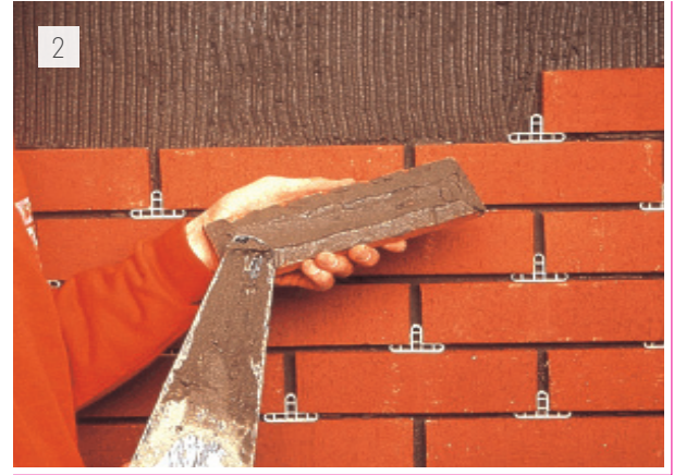
2 Kaplama tuğlası arka yüzüne bir miktar İşıklar Flex Yapıştırıcı sürülerek çıta (metal), ip, plastik derz artışı veya kama yardımı ile 1 cm derzli olarak yüzeye düzgünce yapıştırılır. // A small amount of İşıklar Flex Adhesive is applied to the back of the brick slip and then glued to the surface properly by the help of laths (metal), rope, plastic tile spacer or wedge with 1 cm apart.
